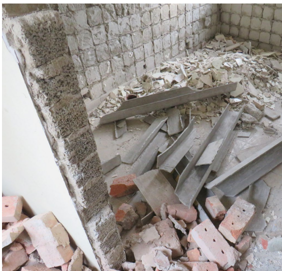
Bild 1: asbesthaltige Fliesenkleber
