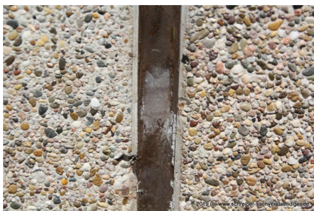
Bild 10: alte Dichtstoffe können als Weichmacher PCB enthalten
