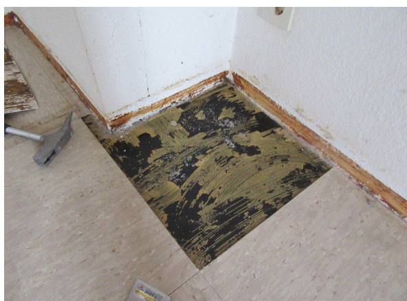
Bild 8: PAK-haltiger Klebstoff unter Bodenbelag
