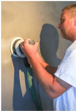
Bild 13: Staubvermeidung durch fachgerechtes Absaugen
