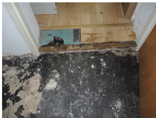
Bild 9: PAK-haltiger Klebstoff unter mehreren Bodenbelägen
