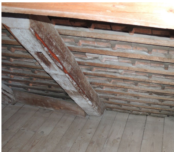
Bild 5: Einsatz z. B. als Holzschutzmittel gegen Insekten im Dachstuhl
