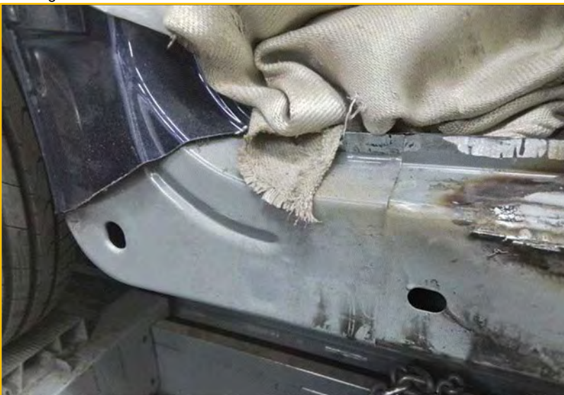
Bild 17: Werkstattbild, Anbindung Verstärkung Unterholm an Verstärkung A-Säule
